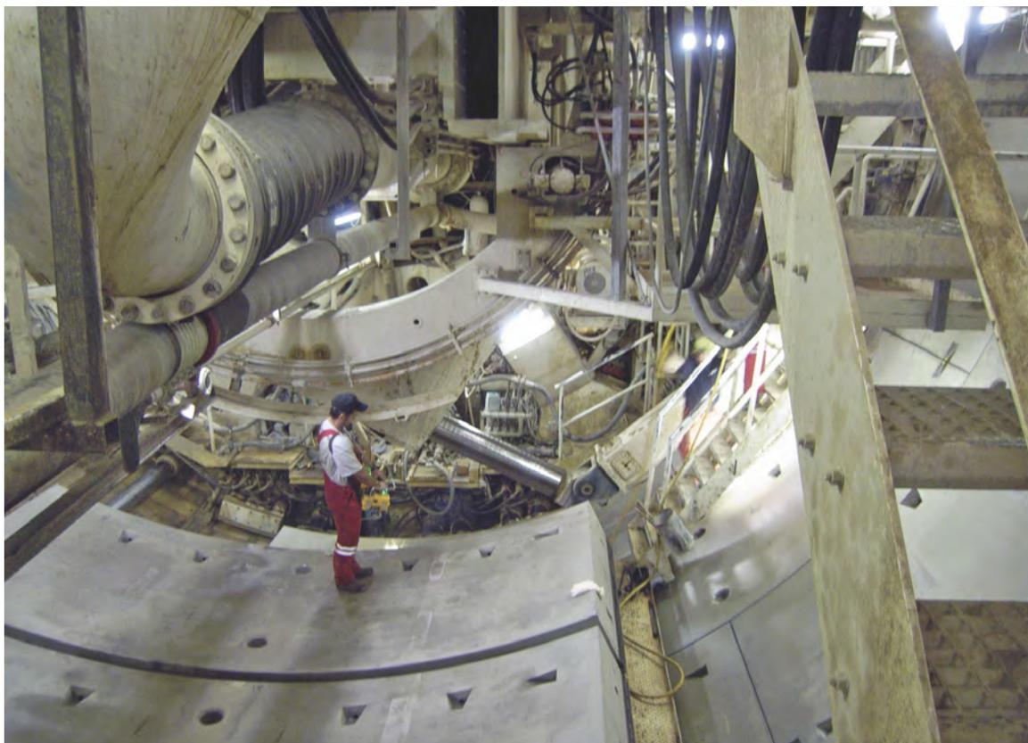
Posa in opera dei conci geotermici nella galleria ferroviaria ad alta velocità a Jenbach, Austria: i 27 anelli attivati sfruttano una superficie di scambio ampia circa 2.000 m<sup>2</sup>, con prestazioni nell'ordine di 10 W/m<sup>2</sup> (Rehau).
